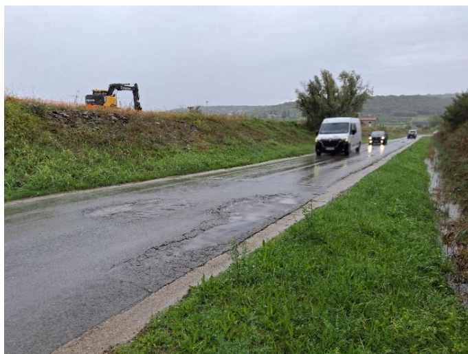
Slika 3: Značilne poškodbe na vozišču, kjer so predvidene lokalne sanacije.
