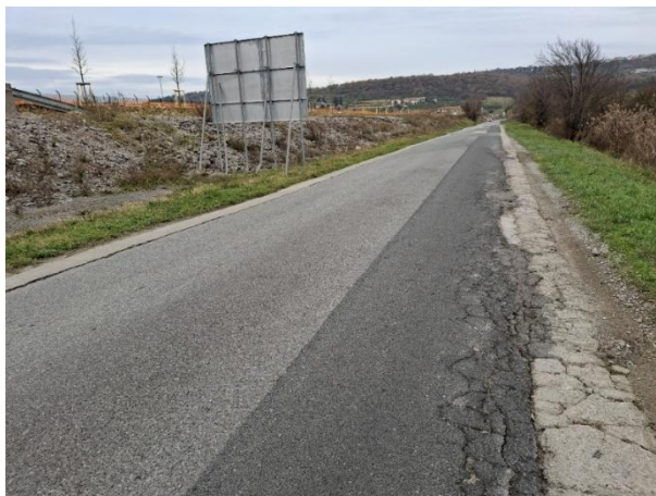
Slika 2: Značilne poškodbe asfaltnega vozišča in betonskih bankin na Železniški cesti.
